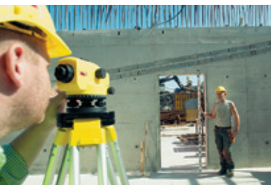
Excavaciones y cimentaciones
